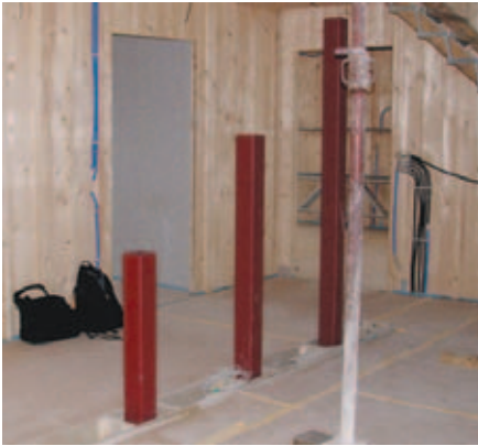
Bild 2 Drei in die Bodenplatten einbetonierte Stahlrohrstützen dienen der Treppe später als Aussteifung.
