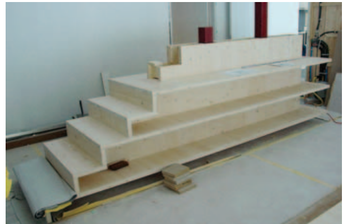
Bild 3 Die Treppe wird segmentweise montiert, immer im Wechsel ein Schachtkasten und ein Regalboden mit bereits zwei angeleiteten Setz- und einer Trittstufe. Jede zweite Trittstufe ist ein Regalboden und umgürtet den Schacht wie ein Ring.
