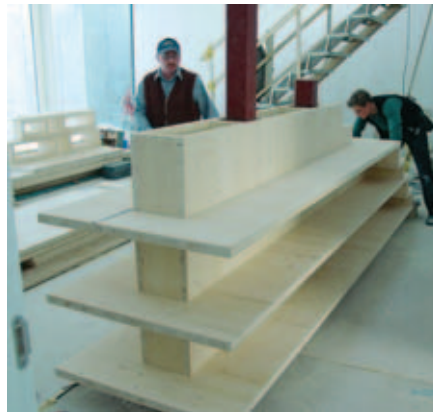
Bild 4 Vier Schachtkästen spannen bereits drei Regalböden nach dem Prinzip in Bild 5 ein. Von den eingespannten Stahlstützen sind nur noch zwei zu sehen.
