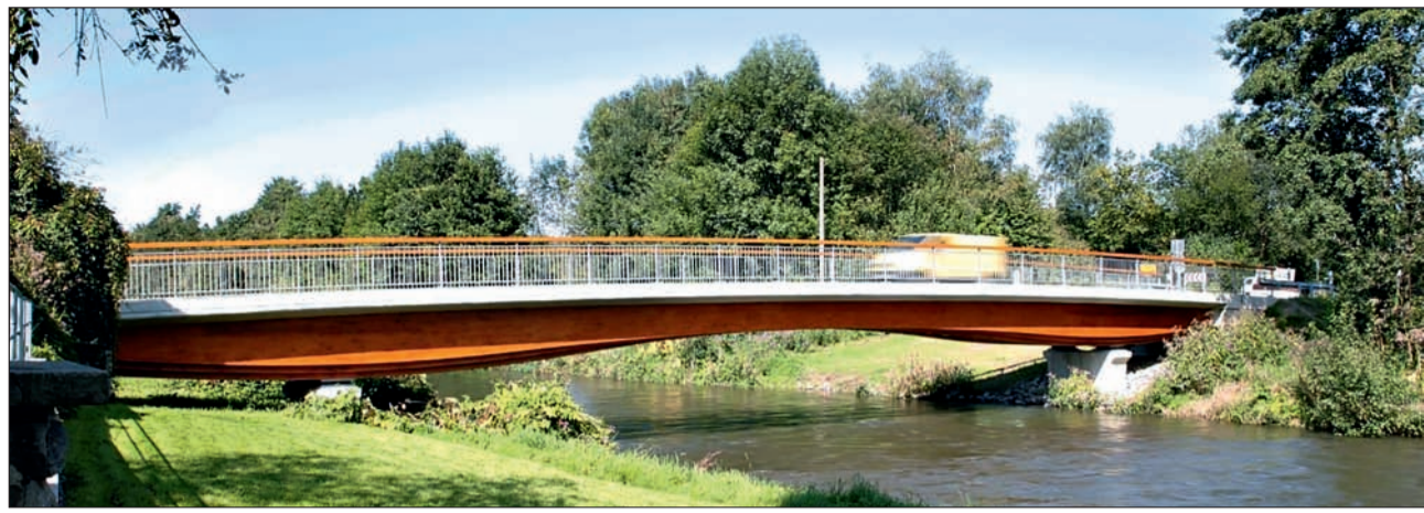
Die neue 40 m lange und 4,75 m breite Holz-Beton-Verbund-Brücke in Lohmar ist dreifeldrig ausgeführt. Das Mittelfeld überspannt 28 m. Die blockverklebten Träger haben eine variable Höhe und abgestufte Unterseiten, entsprechend der aufzunehmenden Kräfte Visualisierung: Schaffitzel + Miebach Faszination Brücken GmbH
