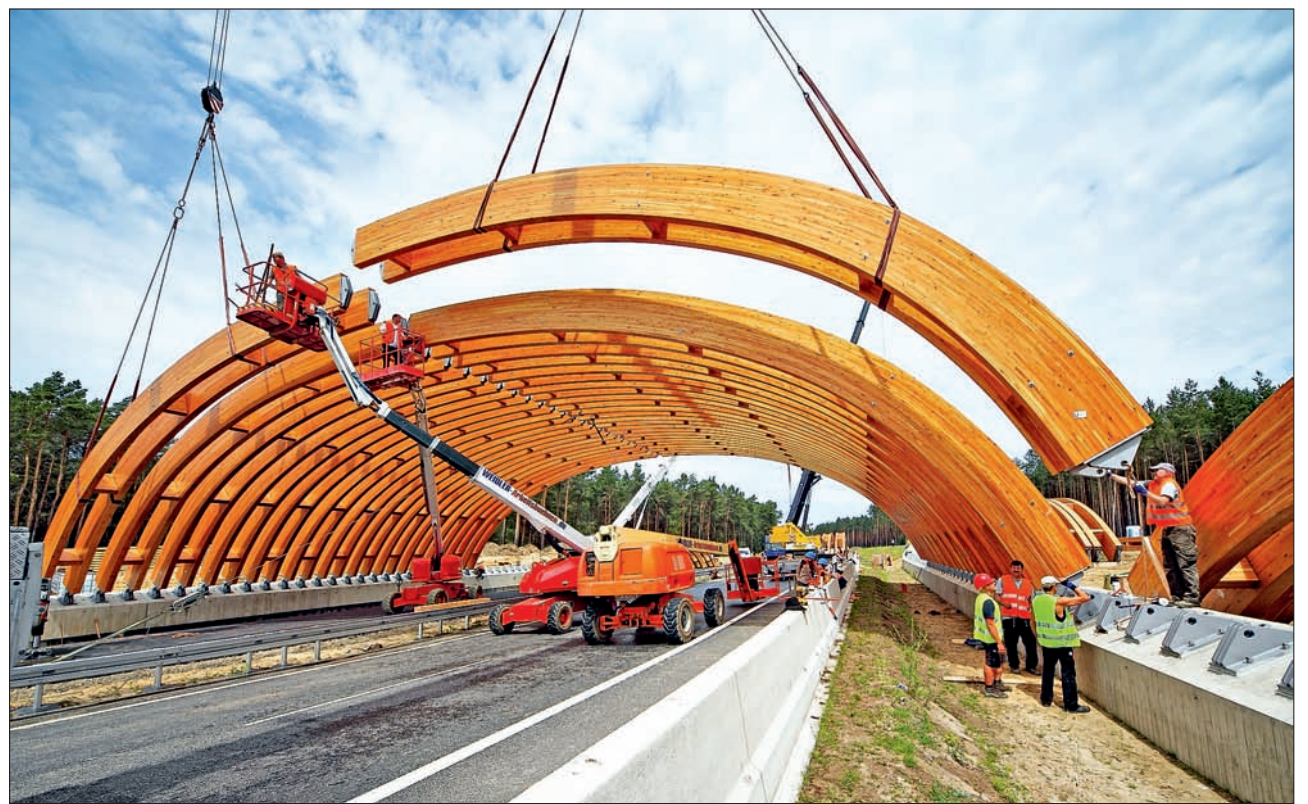
Montage der Grünbrücke über die B 101 bei Luckenwalde: Dreigelenk-Bögen bilden den 40 m langen schalenartigen Deckel, der später mit Erdreich überschüttet wird. Es ist in Deutschland das zweite Querungsbauwerk dieser Art. Eine dritte Grünbrücke in Holz ist aktuell zum Bau freigegeben Foto: Legrand/Deges
