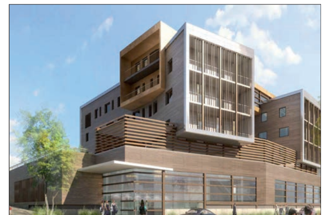
Für den neuen FCBA-Hauptsitz, einen Mehrgeschosser aus sich kreuzenden Gebäuderiegeln, hat der Architekt eine Mischkonstruktion aus Holz, Beton und Stahl gewählt. Quelle: Atelier4plus
