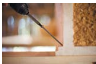
5 | Das erste Element wird auf dem Auflager mit einer schräg eingedrehten selbstbohrenden Holzschraube befestigt.
