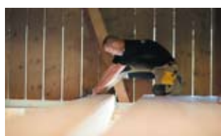
6 | Nacheinander werden die Elemente aufgelegt und zusammengesoben. Beim Zusammenschieben greifen Nut und Feder ineinander.
