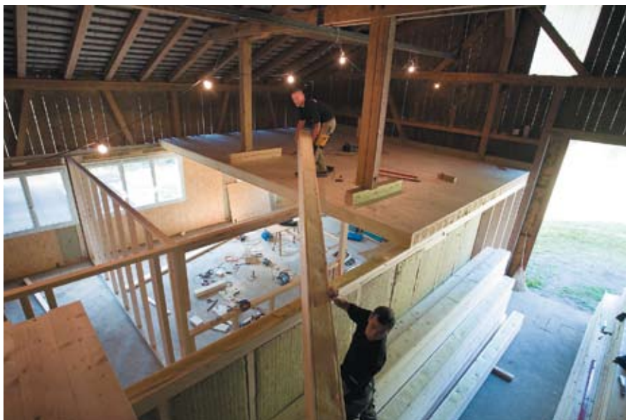
1 | Aufgrund ihres geringen Gewichts lassen sich LIGNATUR® easy-Elemente auch in beengten Räumen und auf Baustellen ohne Transportmöglichkeiten handwerklich verlegen.
