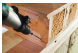
7 | Jedes Hohlkastenelement wird mit dem Auflager verschraubt.
