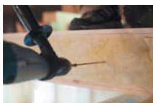
8 | Seitlich eingedrehte selbstbohrende Holzschrauben verbinden die Elemente in horizontaler Richtung.
