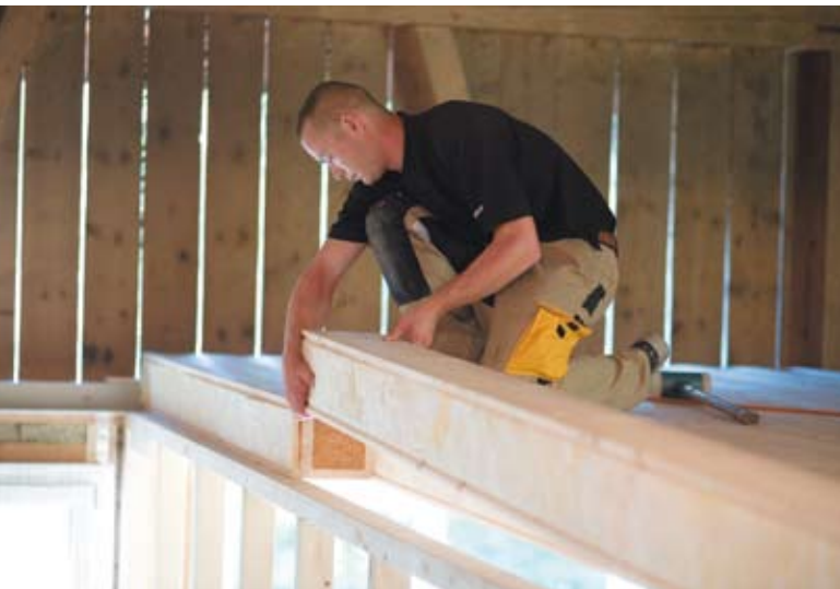
9 | Ein bedeutender wirtschaftlicher Vorteil bei den LIGNATUR® easy-Elementen ist die Möglichkeit, Reststücke im Deckenverband einzubauen. Auf diese Weise gibt es praktisch keinen Verschnitt.
