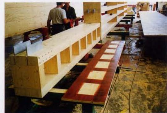
**Bild 3:** Auf die Gerippe werden Kerto-Q-Platten aufgelegt.
