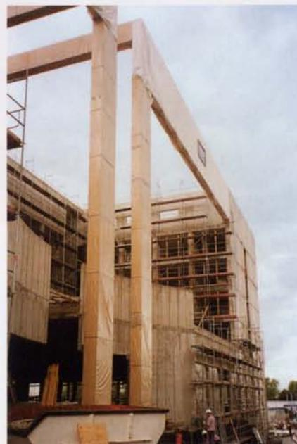
**Bild 5:** Die gegen Feuchtigkeit mit Folie geschützten Holzstützen und -träger sind montiert. Der Putz folgt später.
