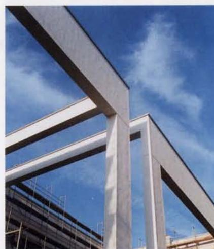
**Bild 6:** Es gibt nur eine horizontale und eine vertikale Putzfuge an den Knotenpunkten Träger/Stütze.
