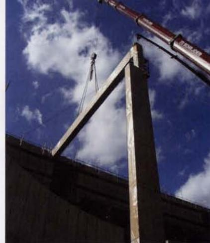
**Bild 4:** An die doppelt ausgeklinkte Stütze wird der erste Nebenträger angeschlossen. Für die Auflagerung des Attikaträgers von links bleibt eine ca. 85 cm breite Auflagerfläche.
