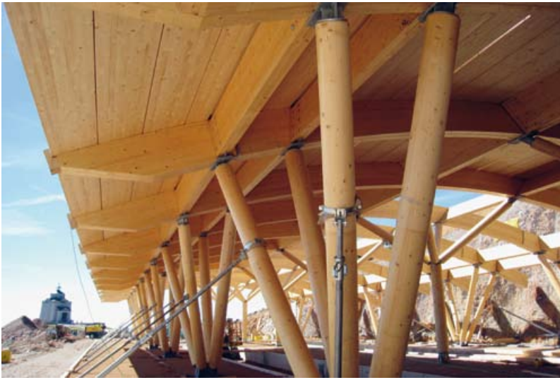
◀ Dachuntersicht der auf Fuge verlegten BS-Holz-Dielen
