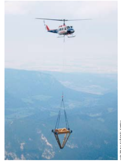
► Der Helikopter bringt's: Tragwerksteile wie z. B. die V-Steher wurden vormontiert eingeflogen
