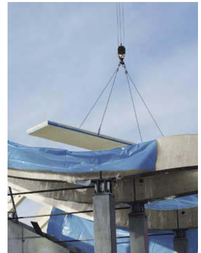
◀ Dreigelenkstabzüge mit Gelenkpunkt Nr. 2. Daran angehängt sind die Bögen für die Ausbildung der Dachform
