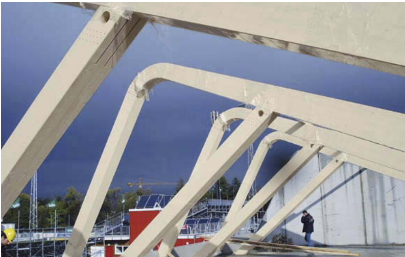
◀ Dreigelenkstabzüge mit Gelenkpunkt Nr. 2. Daran angehängt sind die Bögen für die Ausbildung der Dachform
