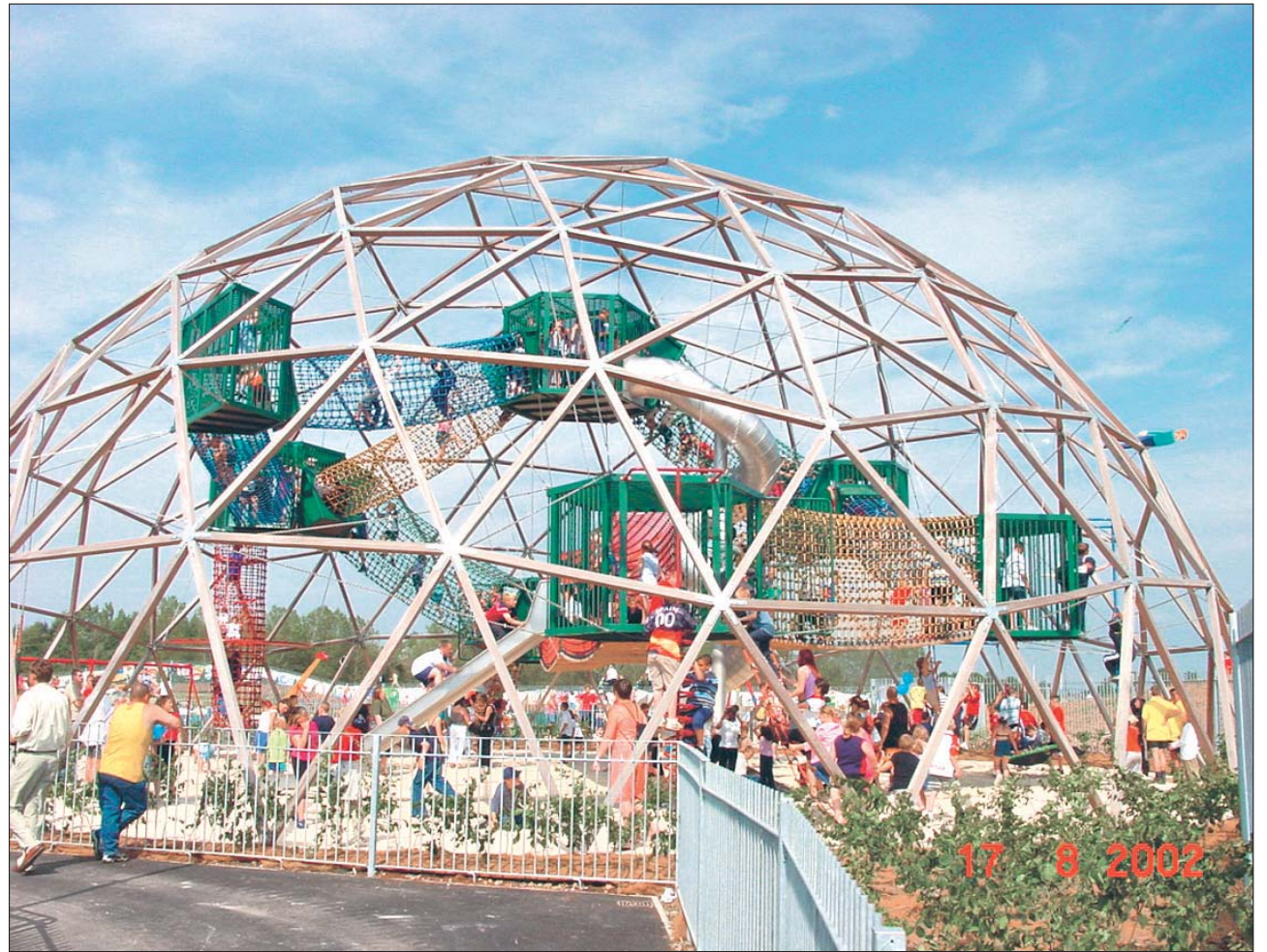
Über einen Spielplatz im Hengrove Park, Bristol (Großbritannien) spannt sich das Holzgerippe einer geodätischen Kuppel.
