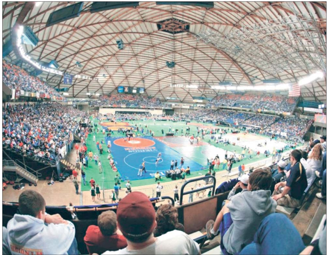
Der Tacoma Dome in der Nähe von Seattle, Washington, USA, wurde als geodätische Kuppel mit sehr großer Spannweite ausgeführt. Foto: Ing.-Büro H. E. Lünig
