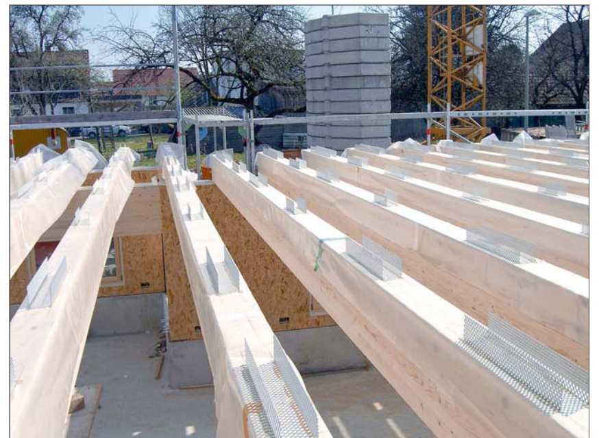
Auf die BS-Holzträger (mit werkseitig eingeklebten Streckmetallen als Schubverbindern) werden hier jetzt anschließend die Filigrandekenelemente aus Beton aufgelegt.
