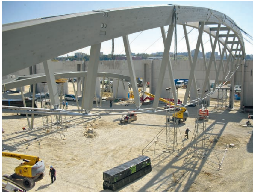
Der Erweiterungsbau des Güterverkehrszentrums in Ingolstadt wurde mit unter-spannten BS-Holz-Trägern ausgeführt. Foto: Wiehag
