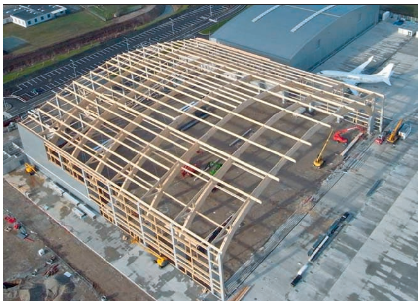
Skelett des Flugzeughangar-Tragwerks aus der Luft. Foto: Holzbau Amann
