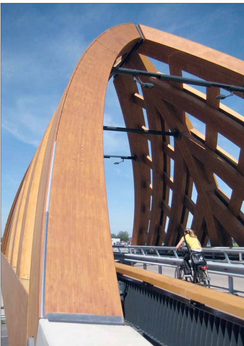
Fachwerkbrücke aus acetyliertem Kiefernholz im niederländischen Sneek (vgl. Bericht im Holz-Zentralblatt Nr. 1/2, Jahrgang 2009) Foto: Stephan Klein
