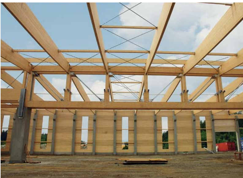
◀ Die Gebäude-maße des Hallenbaus betragen 70 m in der Länge und etwa 52 m in der Breite. Die Traufhöhe liegt bei ungefähr 11 m
