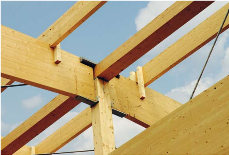
◀ Ausgeführter Anschluss Fischbauträger an 20-m-Fachwerk
