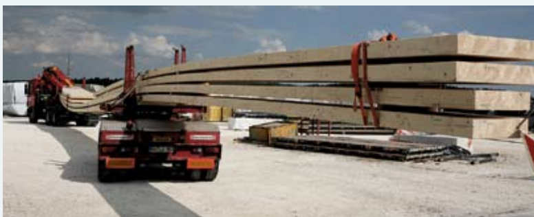
Anlieferung der BS-Holz-Hauptträger auf dem Gelände der ausführenden Holzbaufirma zur Vorfertigung der Brückenteile
