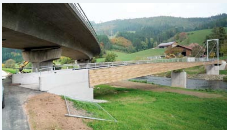
Von der B-33-Brücke aus konnte der Frohnausteg mit einem Montagekran errichtet werden.
