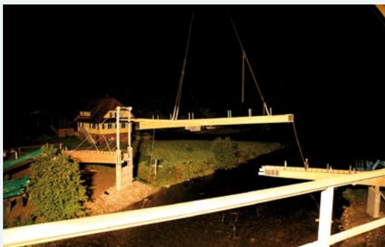
Montage bei Nacht: Ein spannender Moment ist immer das Einpassen des letzten Bauteils.
