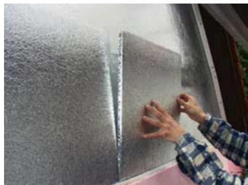
Einbau von VIP mit Hilfe eines Schienensystems
