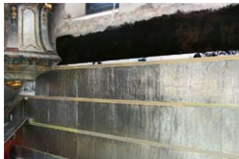
VIP als Innenraumdämmung in einer Kirche. Für unregelmäßig beheizte Räume wie z. B. Versammlungsräume oder Kirchen sind VIP besonders geeignet, weil es hier auf schnelles Aufheizen ankommt
