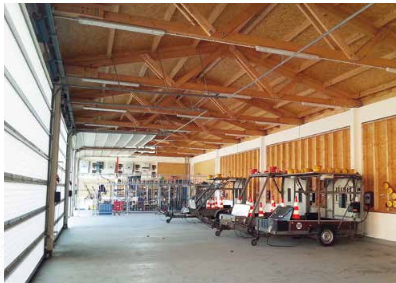
◀ Mit 84 m ist die Lagerhalle samt überdachtem Außenlager das längste Gebäude der Meistereier. In die Bodenplatte sind Stützen aus Stahlbeton eingespannt
