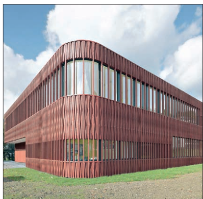
Schulhaus Büttigen in Luzern: Die auf die innere Nutzung des Schulhauses abgestimmte ornamentale Fassadenstruktur reagiert mit unterschiedlichen Öffnungsgraden. Foto: Roger Frei
