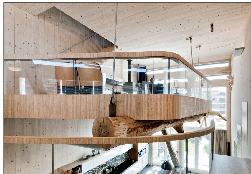
Ein ganzer Baumstamm dient im „Schwarzen Haus“ als Deckenträger und ist gleichzeitig Raumskulptur. Foto: Peter Föllmi
