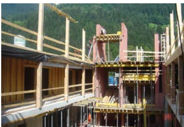
Bild 11 Die an den Stirnseiten des Atriums angeordneten Aufzugsschächte und Treppenhäuser aus Stahlbeton sowie die BS-Holz-Stützen dienen als Auflager für die Deckenelemente der Verkehrsflächen.
