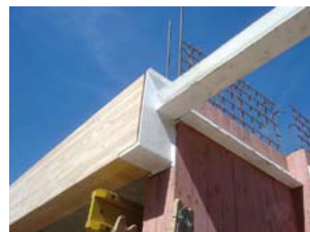
Bild 13 Brandschutzbeschichtete Stahlträger. Großer Aufwand, um „Flachdecken“ zu erreichen, von denen im Gangbereich die Installationen abgehängt wurden.
